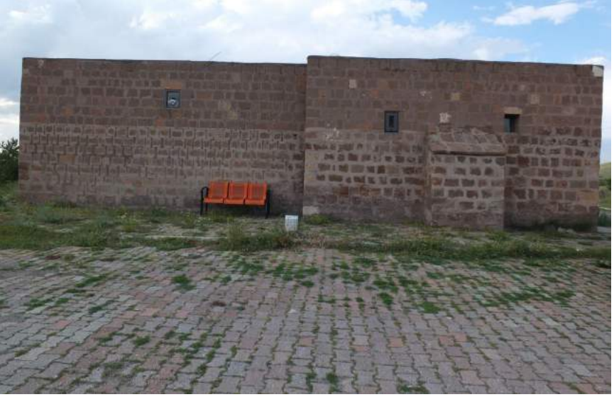
Fotoğraf 1-Turesan Veli Zaviyesi'nin güney cephesi ve güneydeki alan (18. 06. 2018)
